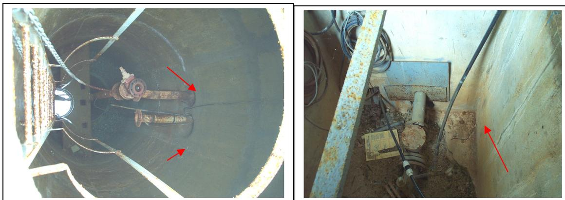
L'étanchéité de la base de chambre de tirage réalisée à 3 mètres du puits devra être réalisée.
