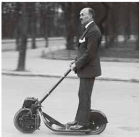
■ *Un ancêtre de la trottinette électrique, l'autoped à moteur à essence en 1917.*
